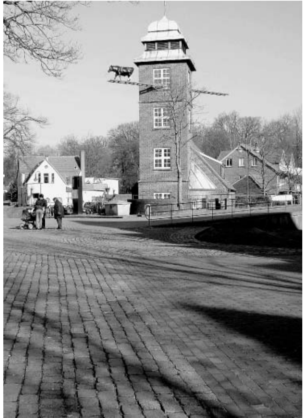
Blick über den Scharmbecker Marktplatz auf den alten Schlauchturner der Feuerwehr. Die Planer hoffen auf einen Neubau. Denn die Stadt braucht Gastronomie. FOTO: HARRY LAUBE
