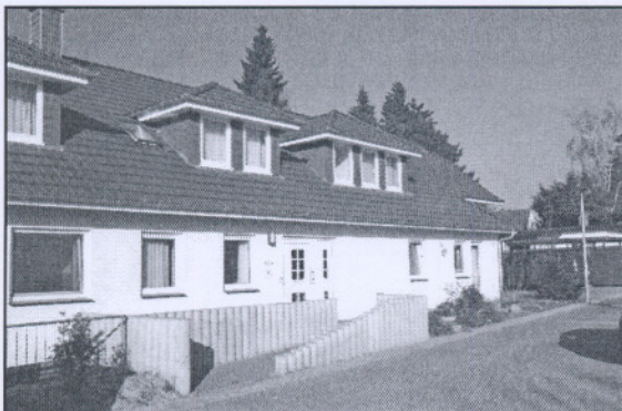
Seitenansicht des Wohn- und Pflegeheims Lesmona nach dem Umbau 2002 – Haus 2
